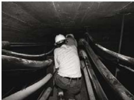
À guisa de esclarecimento, a operação de emenda termocontrátil consistia no aquecimento de quatro tubos de material termocontrátil, os quais são colocados um a um, sucessivamente, sobre a emenda dos segmentos do cabo a ser unido e aquecido até que, devido a sua retração operada pelo calor fornecido por uma fonte externa, operem a união dos segmentos do cabo<sup>3</sup>.
